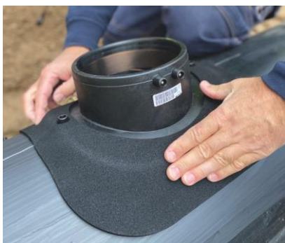
Covorașul autoadeziv din cauciuc etanșează șaua pe o conductă ASA VL d160.
