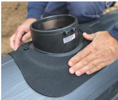
Öntapadó gumiszőnyeg zárja le a nyeregidomot, a képen egy ASA VL d160 csövön.
